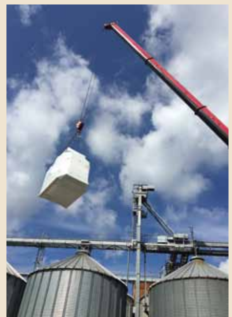
Abb. 1 Einheben der Getreidereinigungsmaschine
